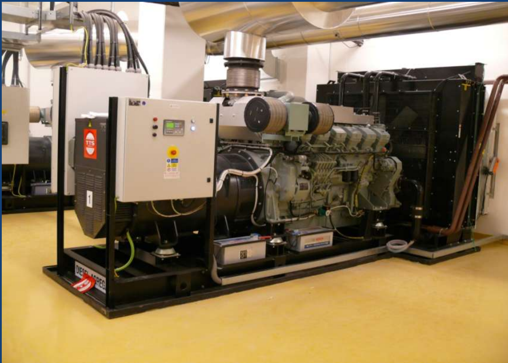
Pohled do strojovny náhradního zdroje v 1.PP
