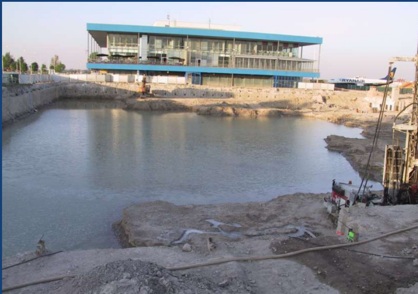
Hloubení základové jámy – „Terminál nad jezerem“
