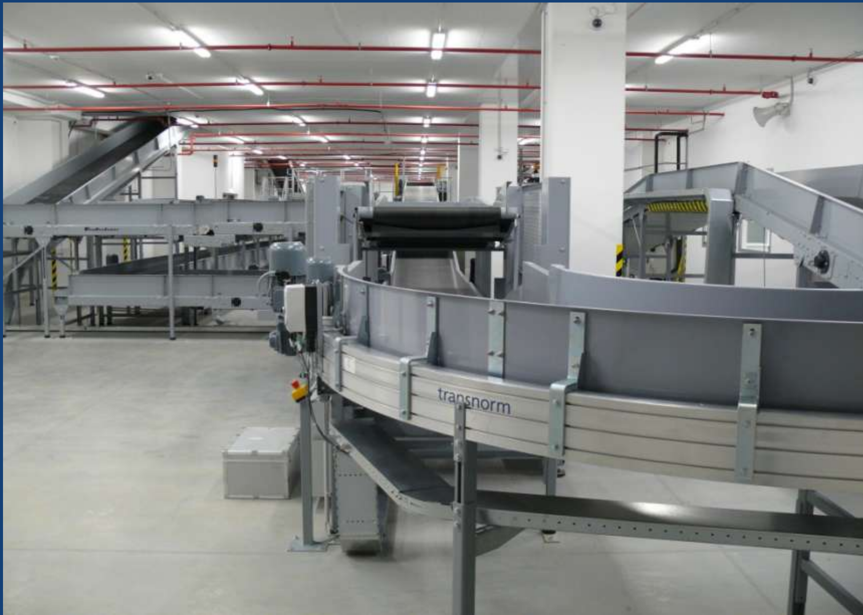
Pohled do haly BHS v 1.PP – bezpečnostní kontrola zavazadel
