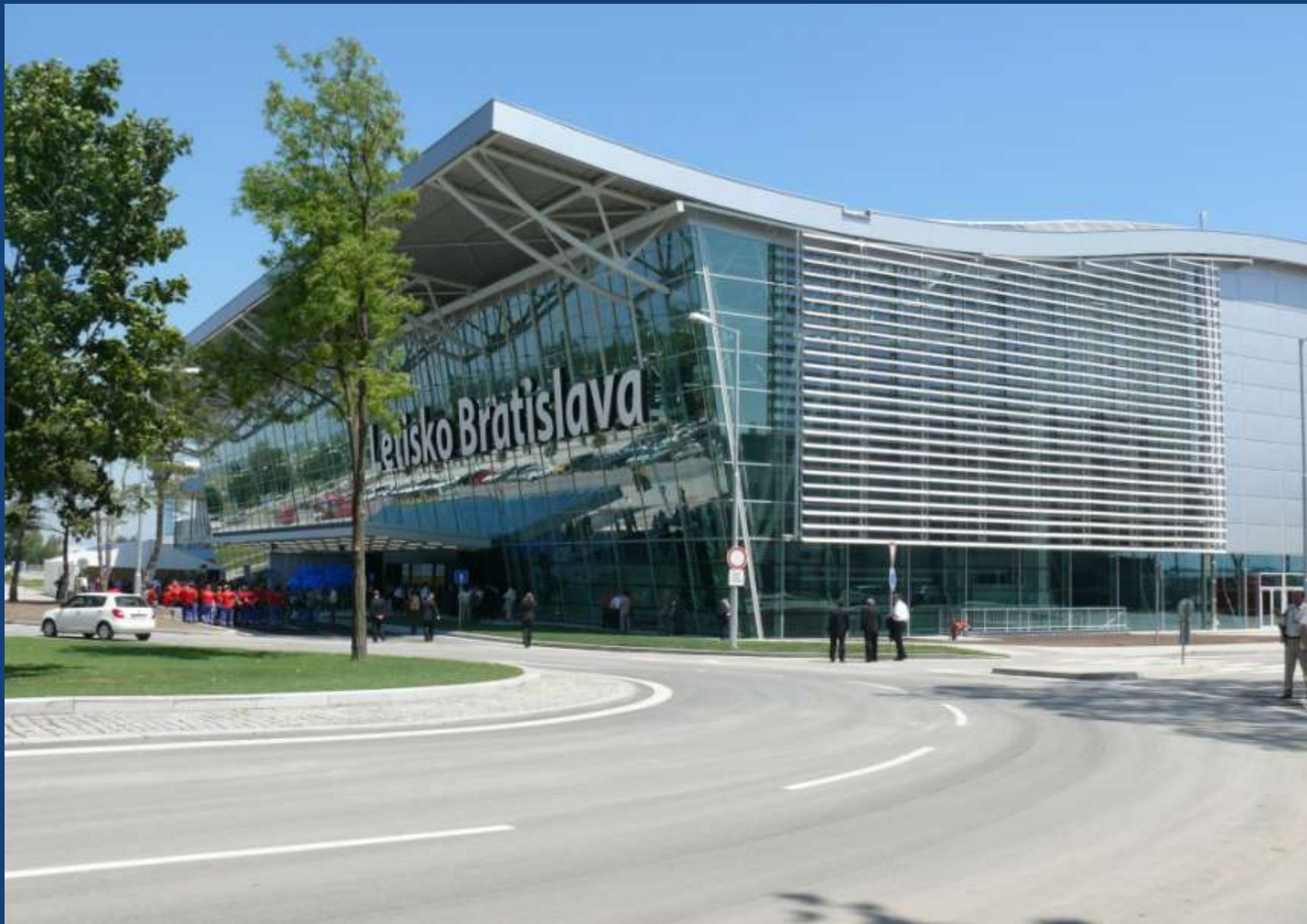
Pohled na nový Terminál z přednádraží - 1. etapa
