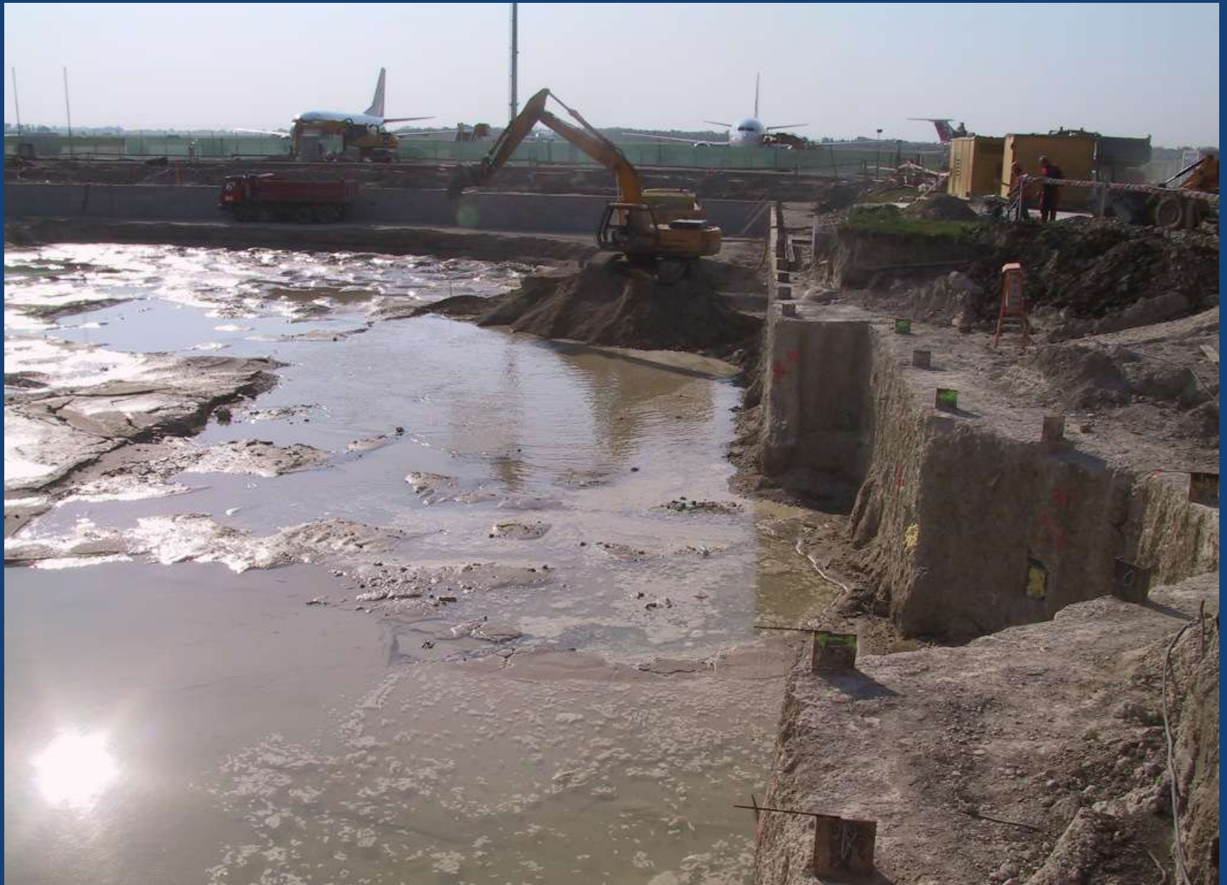
Hloubení základové jámy
