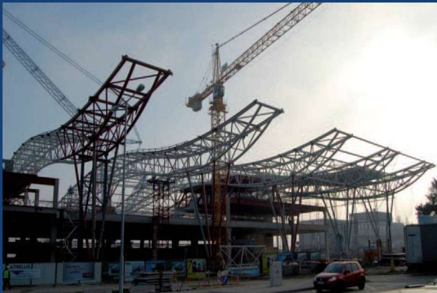
Ukládání ocelových střešních vazníků
