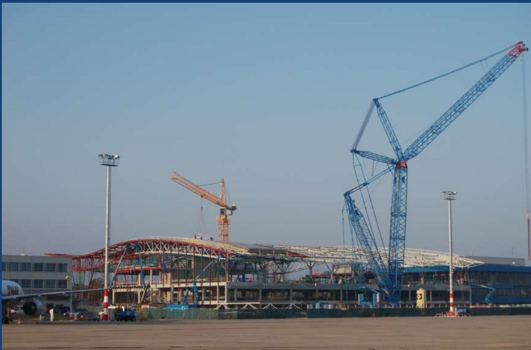
Pohled na nosnou konstrukci z letištní strany
