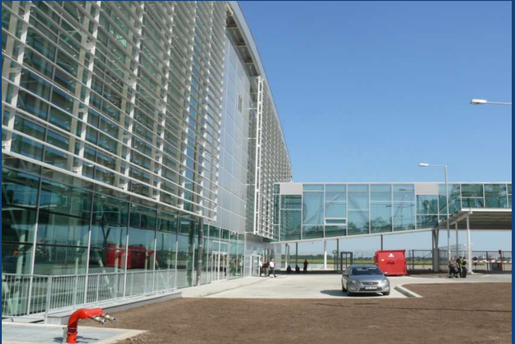
Pohled na spojovací objekt (most D) mezi novým Terminálem a objektem GAT
