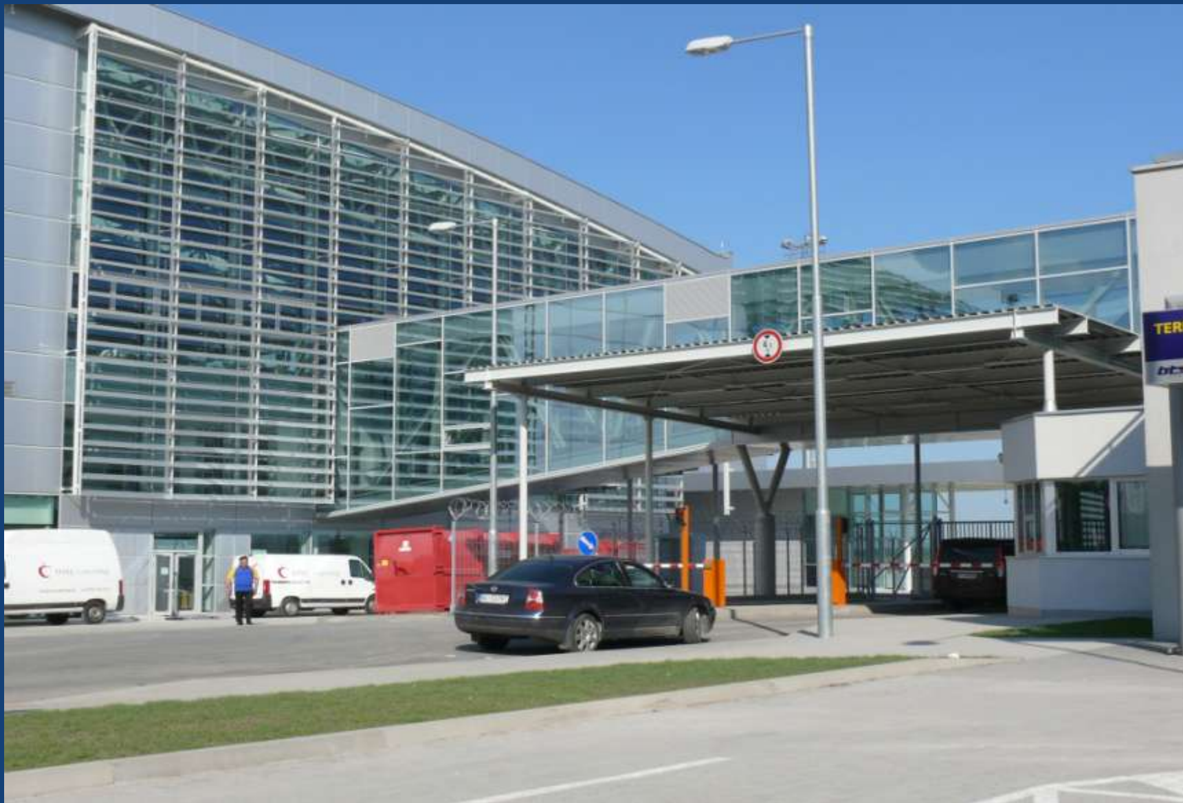
Pohled na spojovací objekt (most D) a vrátnici mezi novým Terminálem a objektem GAT
