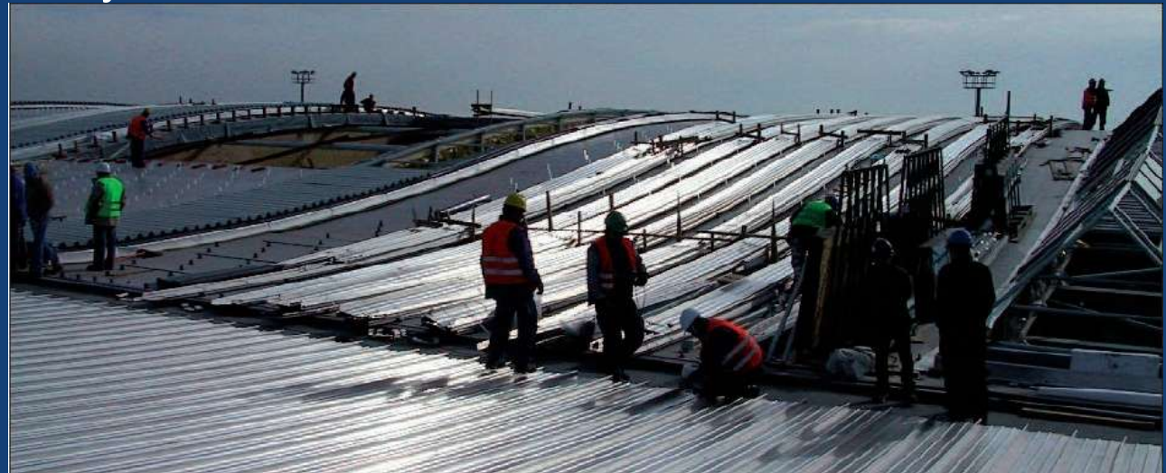
Pokládka střešní krytiny, instalace světlíků
