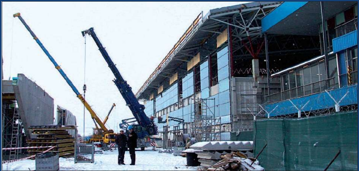
Montáž skleněné fasády
