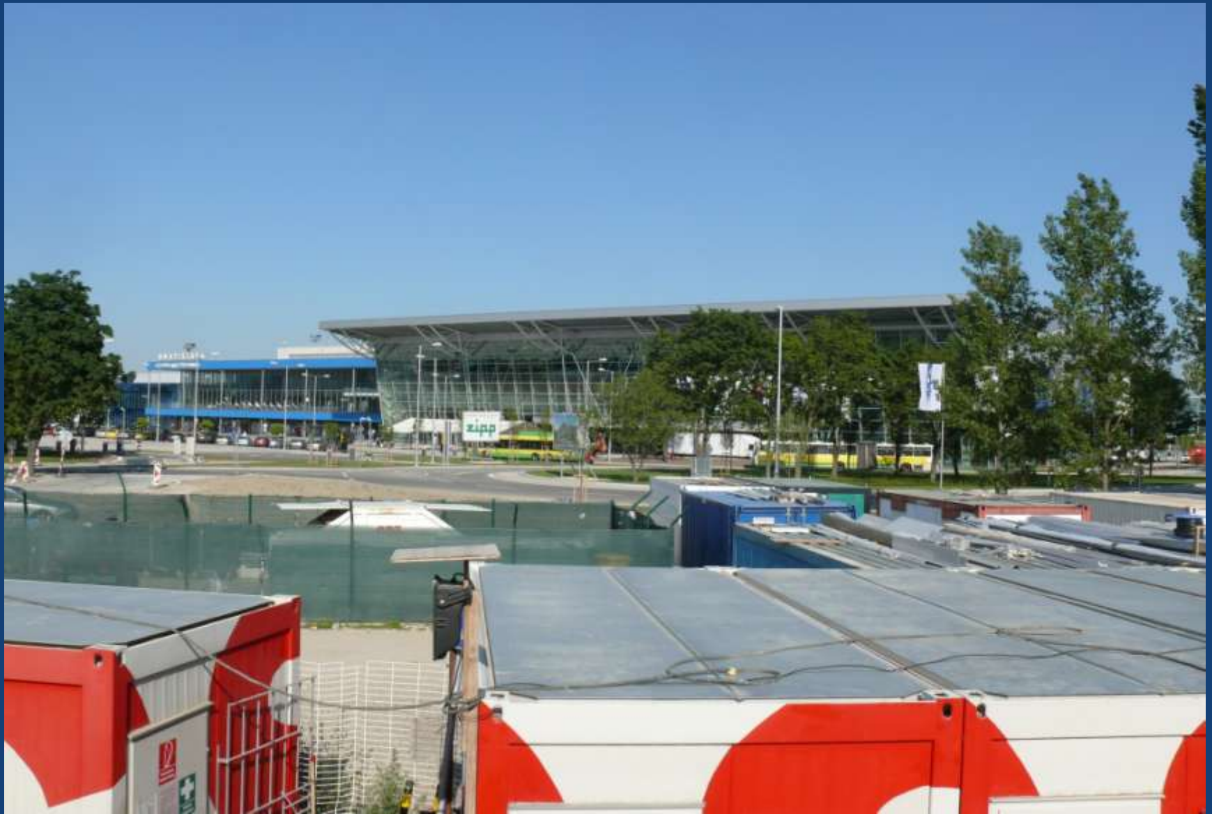
Pohled z přednádraží – z leva starý Terminál (1971), nový Terminál - 1. etapa (2010)
