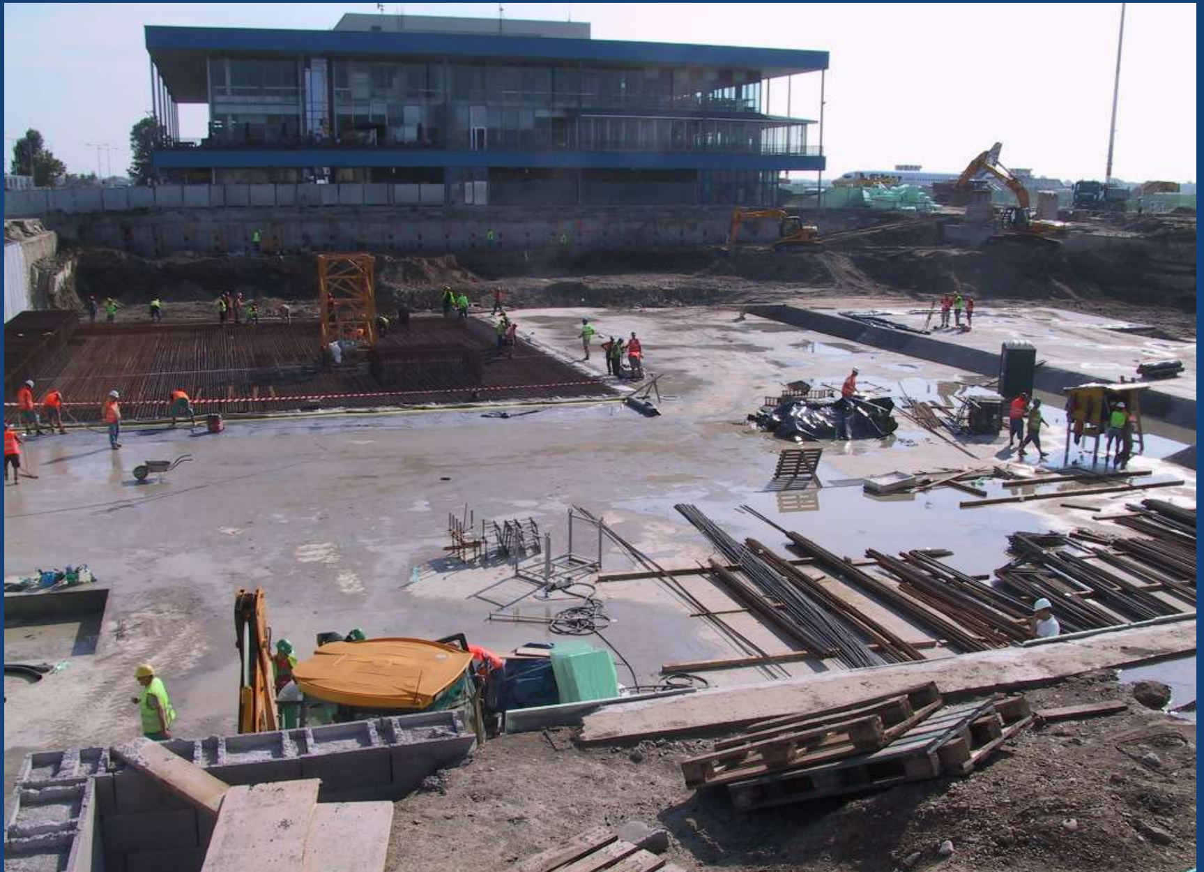
Realizace základové desky
