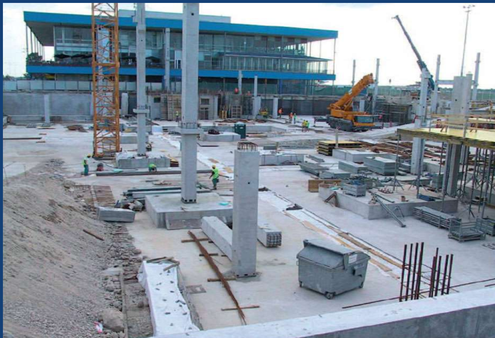
Osazování prefabrikované nosné konstrukce
