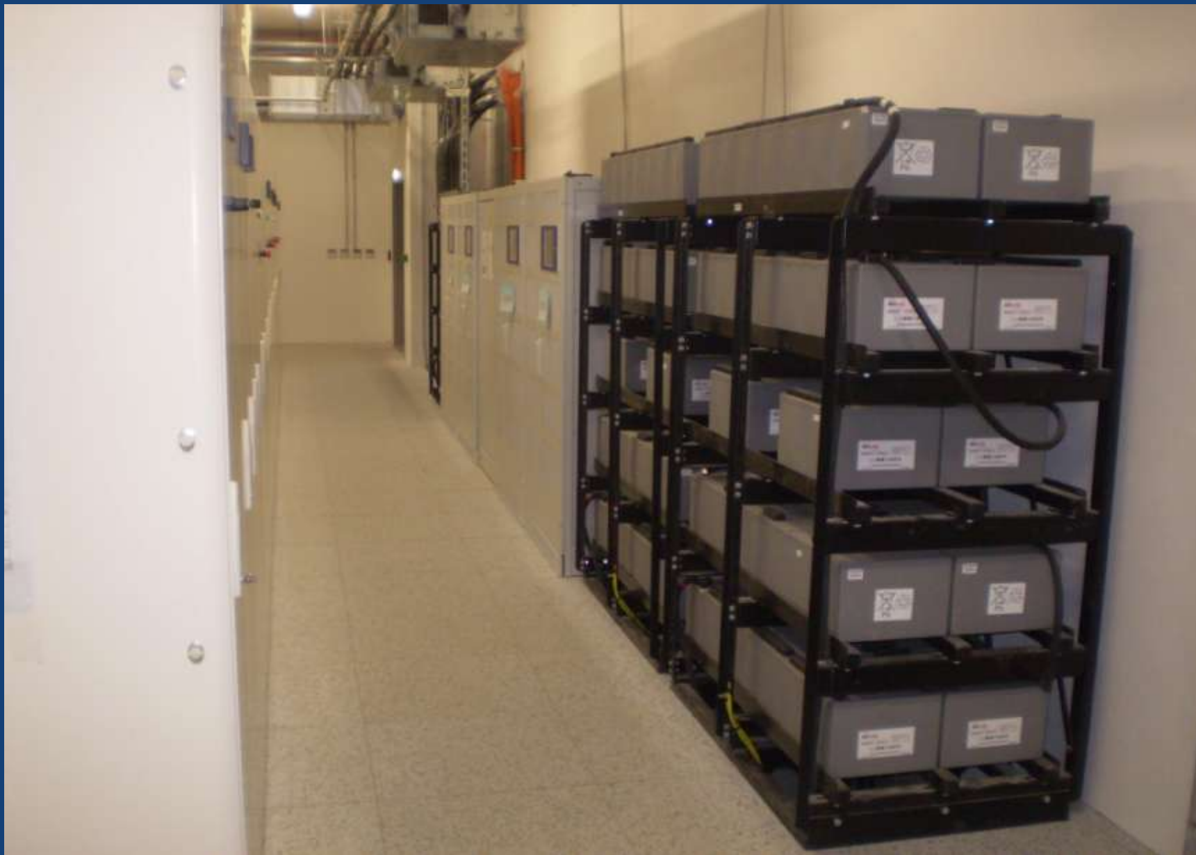
Pohled do elektrické rozvodny NN v 1.PP se záložním zdrojem UPS
