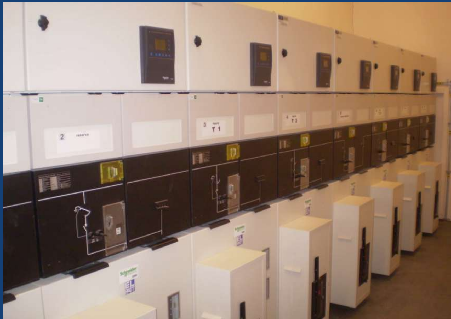
Pohled do elektrické rozvodny VN v 1.PP
