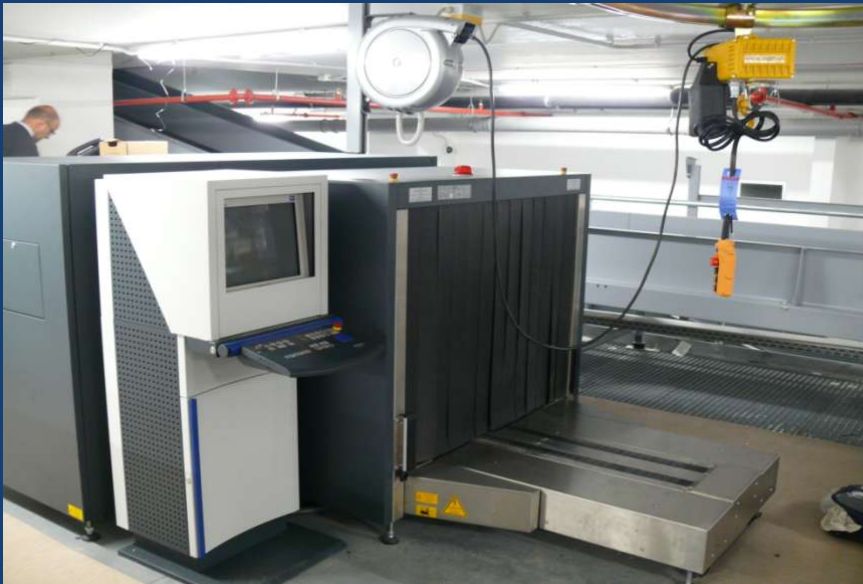
Pohled na rentgen level 5, systému BHS v 1.PP – bezpečnostní kontrola zavazadel
