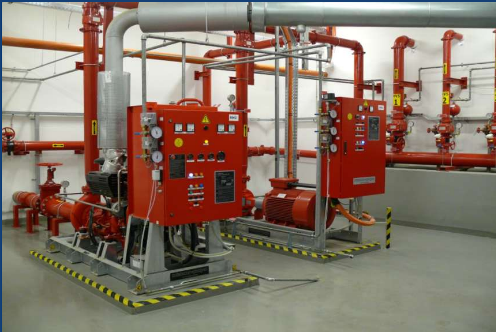
Pohled do strojovny výměňkové stanice v 1.PP
